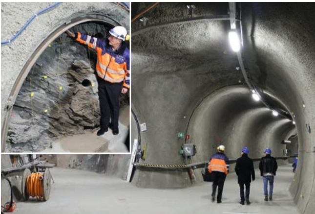
Abb. 4: Das Mont-Terri-Felslabor im Schweizer Kanton Jura bietet eine erstklassige Infrastruktur zur Durchführung verschiedenster geowissenschaftlicher Experimente. Foto links oben: Einen direkten Zugang zum Opalinuston erlauben Fensteröffnungen in den mit Spritzbeton bewehrten Stollen. (Fotos: S. Lüth, GFZ)
