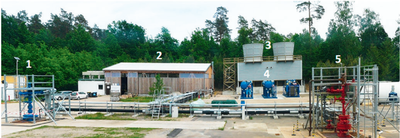
Abb. 4: Infrastruktur am Standort Groß Schönebeck: 1–Injektionsbohrung, 2–Technikhalle, 3–Kühlturm, 4–Binärkraftwerkmodule und 5–Förderbohrung (Foto: GFZ)
