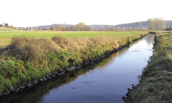
Beispielstrecke Lauter, stark begradigter Abschnitt
