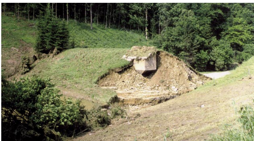
Dammbruch am Hochwasserrückhaltebecken Gissigheim 1984
