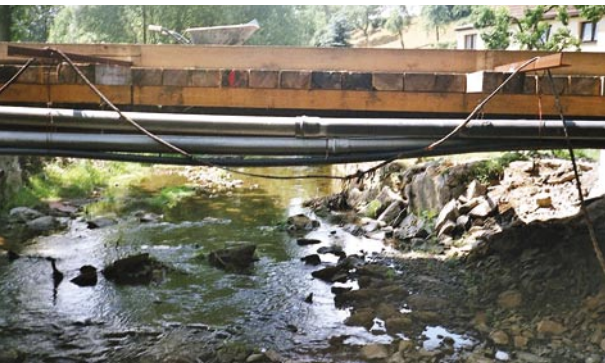
Schadensbeseitigung nach dem Hochwasser 2002 im Einzugsgebiet der Mulde
