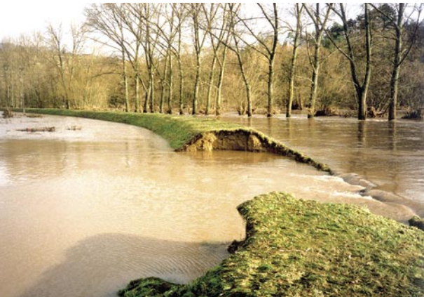
Deichbruch an der Enz bei Rofsag 1993
