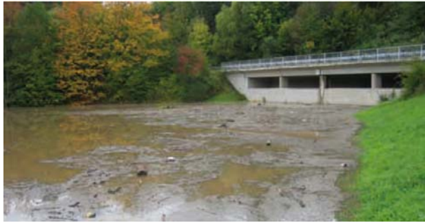
Abb. 4-47: Einstau des Rückhaltebeckens Eicherscheid im Oberlauf der Erft bis knapp unter die Hochwasserentlastung am 28.09.2007
