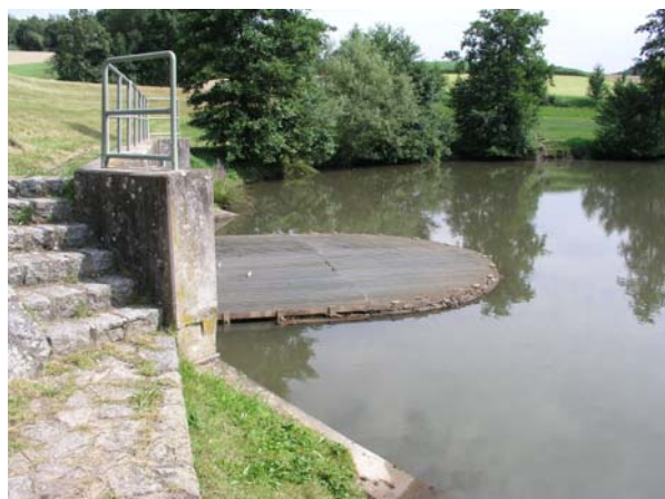
Abb. 6-13: HRB Mörlenbach im EZG der Weschnitz (Hessen): Rückhalteraum mit Dauerstau (Foto: Nienhaus 2007)
