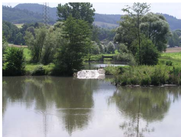
Abb. 6-14: Vorbecken des HRB Mörlenbach im EZG der Weschnitz: Das Vorbecken ist durch eine raue Rampe vom Hauptstauraum getrennt (Foto: Nienhaus 2007)
