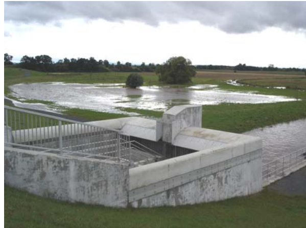
Abb. 3-3: HRB Niederberg am Rotbach (Erft); Rückhalt von belastete Sedimenten durch den oh. liegenden Kommerner See
