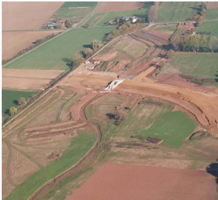
Abb. 6-1: Das Rückhaltebecken Niederberg am Rotbach (Erft) im Bau
