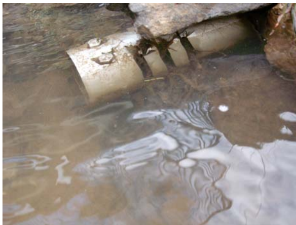
Abb. 4-41: Eingebaute Trübungssonde am Pegel Schwerfen / Rotbach (Erft)
