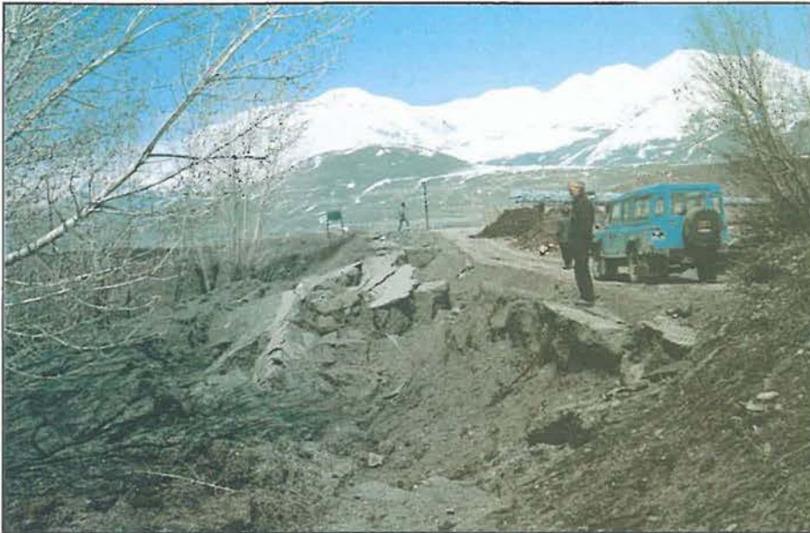
Abb. 5: Abrutschung einer Straßenböschung. Die Straße befand sich auf einem aufgeschütteten Damm in südöstlichen Teil des Erzincanbeckens.
