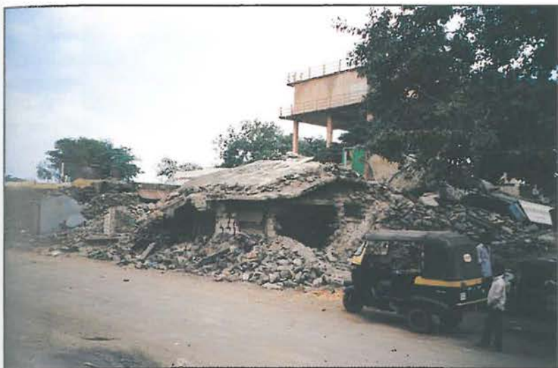
Abb. 13: Schäden an Gebäuden in traditioneller Bauweise. Der Wasserbehälter im Hintergrund blieb unverehrt
