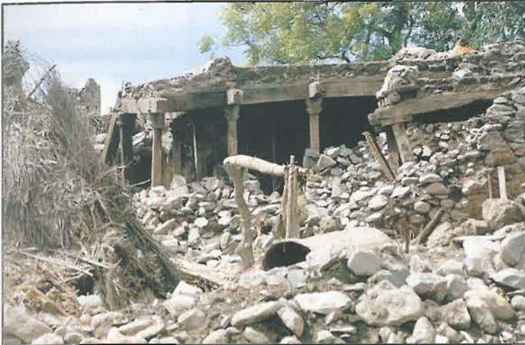
Abb. 1: Wohnhaus in Killari (Südindien), zerstört durch ein Beben der Stärke 6.3 in der Nacht vom 30. September zum 1. Oktober 1993
