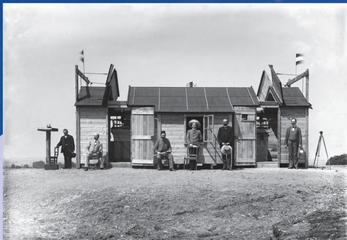
Schon zu Beginn der gemeinsamen Arbeiten zur Gradmessung wurden astronomisch geodätische Messungen auf Expeditionen vorgenommen, wie hier mit zwei Passageinstrumenten. *Already at the beginning of the united work on the arc measurement astronomical geodetic observations were performed on joint expeditions, like here with two passage instruments.*
