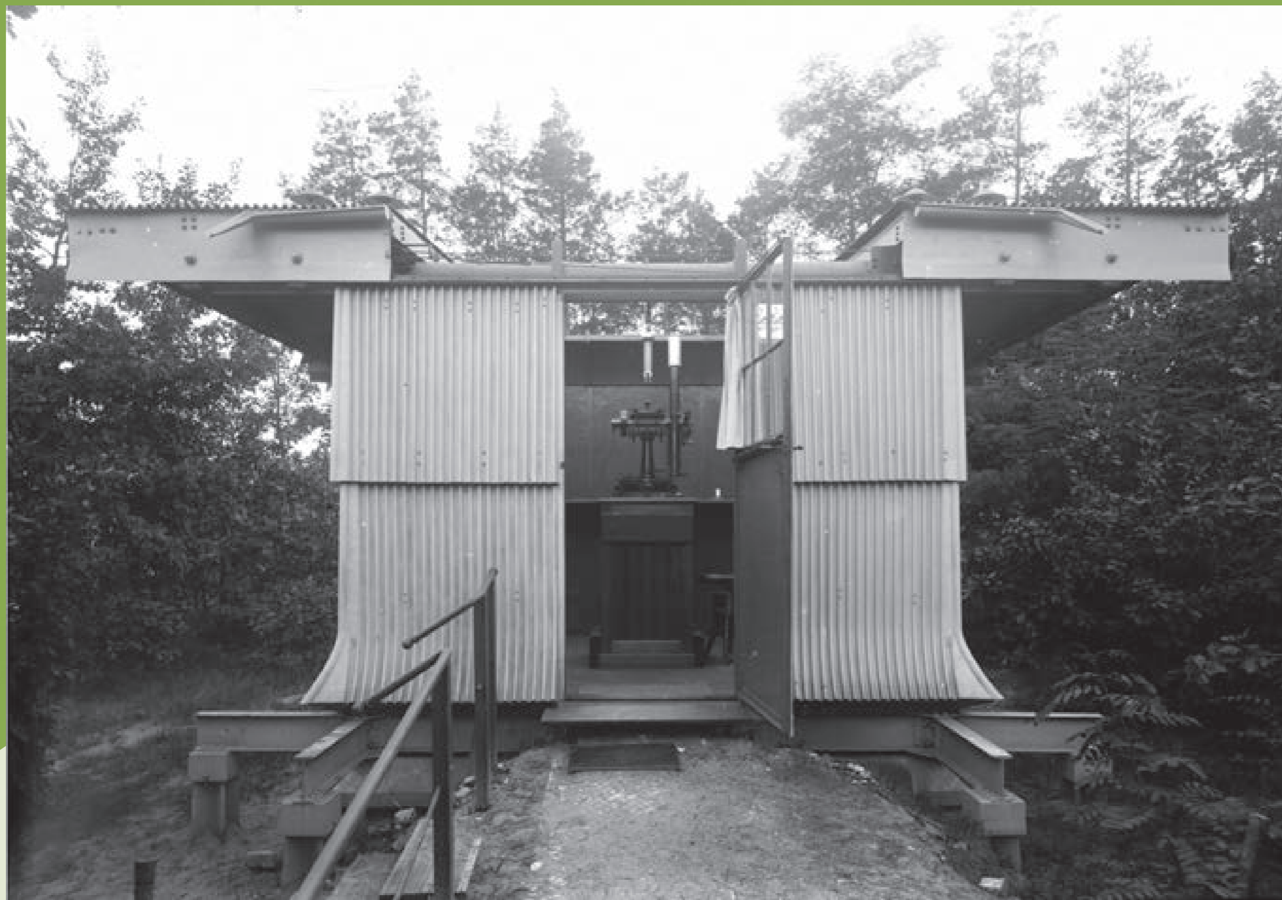
Das Zenitteleskop ist im Breitenhaus des geodätischen Institutes zur nächtlichen Beobachtung aufgestellt. The zenith telescope is situated in the Latitude Building of the Geodetic Institute for night-time observation.
