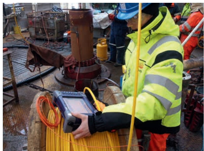
Abb. 2: Installation eines faseroptischen Kabels (gelb) während des Einbaus der Verrohrung in der Bohrung RN-34 im Reykjanes-Geothermiefeld, Island (Foto: M. Poser, GFZ)
