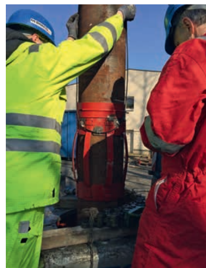
Einbau der Verrohrung mit faseroptischem Messkabel am 9. März 2016 (Foto: K. Erbas, GFZ)
