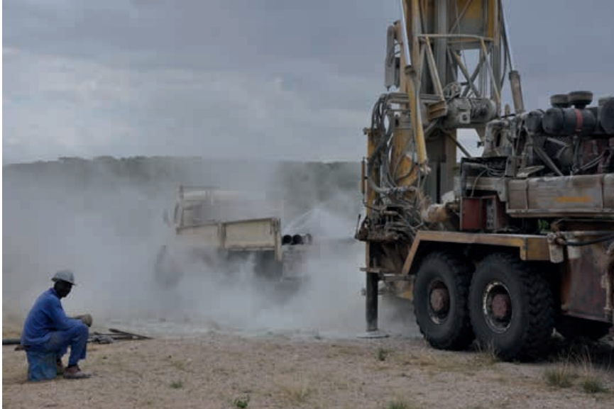
Ausführungen von Bohrungen für seismische Messungen (Foto: C. Haberland, GFZ)
