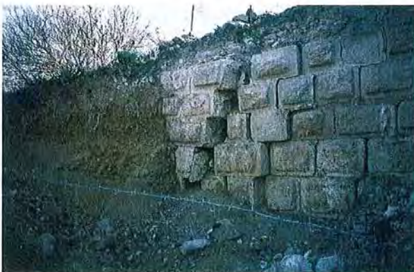
Abb. 3: Mauer einer Kreuzfahrerburg nördlich des See Genezareth, die am 20. Mai 1202 durch ein Erdbeben zerstört wurde (laterale Verschiebung ca. 1,6 m [2]). Das Gelände im Hintergrund ist relativ zum Vordergrund nach links verschoben. (Mit freundlicher Genehmigung von R. Ellenblum, S. Marco, A. Agnon, Hebrew Univ., Jerusalem).
