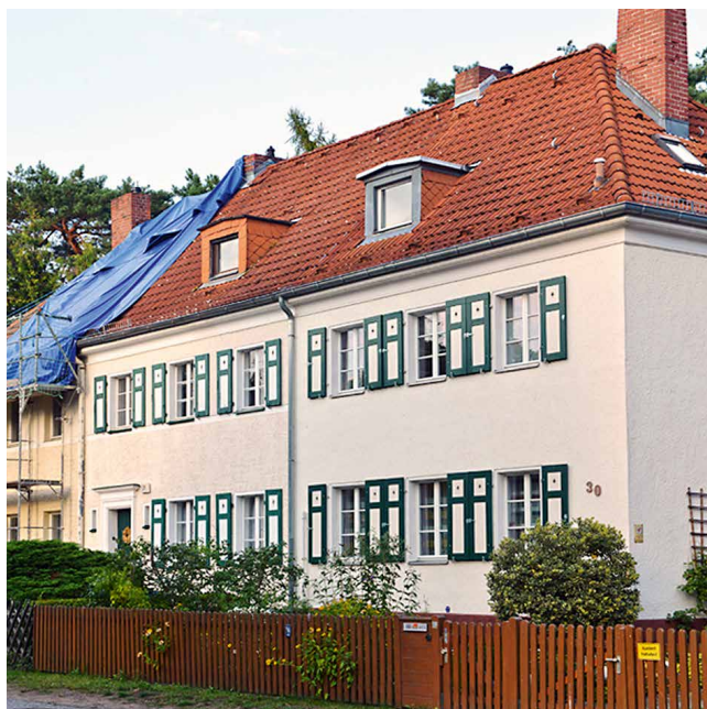
Dreierreihenhaus in der Siedlung Heerstraße (Fotos: DSK)
