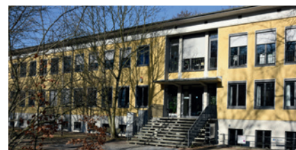
Abb. 2: Gebäude A43, in welchem heute die Potsdamer Forschungsstelle des Alfred-Wegener-Instituts beheimatet ist. Im Keller (Fenster unten rechts) war bis 1998 die Isotopengeochemie untergebracht. Dazu wurden Reinraumlabor und klimatisierte Räume für zwei Thermionenmassenspektrometer (TIMS) sowie ein Büroraum eingerichtet. (Foto: E. Gantz, GFZ)
