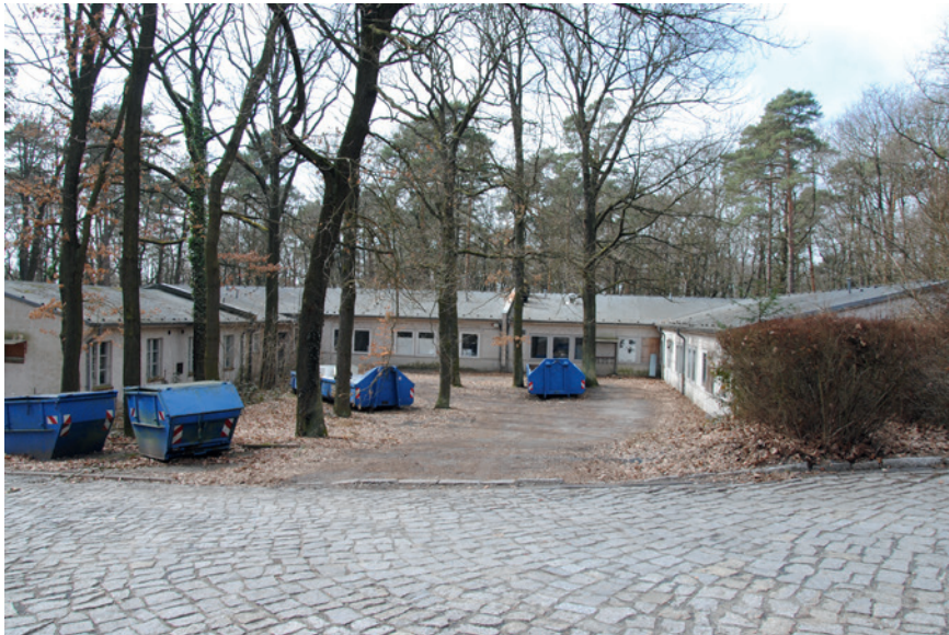
Abb. 1: Ehemalige „Baracke“ A50 und A24 (links). Beide Gebäude mussten für das neue PIK-Hauptgebäude Platz machen und wurden kürzlich abgerissen. Im rechten Barackenteil und im Gebäude A24 waren einige Labore und Büros des Projektbereichs „Geochemie“ untergebracht und im Mittelteil residierte der PB Lagerstättenforschung. (Foto: S. Tonn, GFZ)
