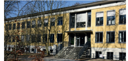
Abb. 2: Gebäude A43, in welchem heute die Potsdamer Forschungsstelle des Alfred-Wegener-Instituts beheimatet ist. Im Keller (Fenster unten rechts) war bis 1998 die Isotopengeochemie untergebracht. Dazu wurden Reinraumlabore und klimatisierte Räume für zwei Thermionenmassenspektrometer (TIMS) sowie ein Büroraum eingerichtet. (Foto: E. Gantz, GFZ)
