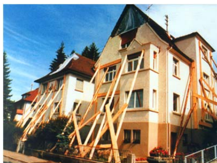
Abbildung 8: Schäden vom Albstadt-Beben am 03.09.1978 in Tailfingen (Baden-Württemberg)
