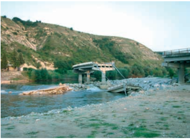
Abb. 7a, b: Schäden an der Verkehrsinfrastruktur durch Hochwassereinwirkung (Bulgarien, Juli 2005, Fotos: A. Thieken, GFZ)
