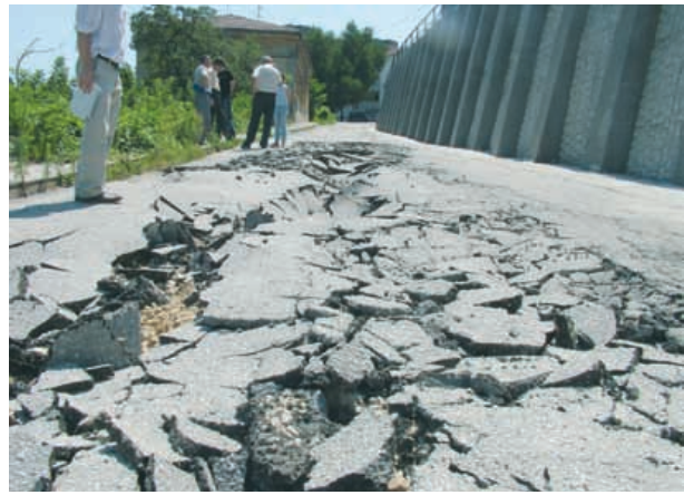
Abb. 7a, b: Schäden an der Verkehrsinfrastruktur durch Hochwassereinwirkung (Bulgarien, Juli 2005, Fotos: A. Thieken, GFZ)
