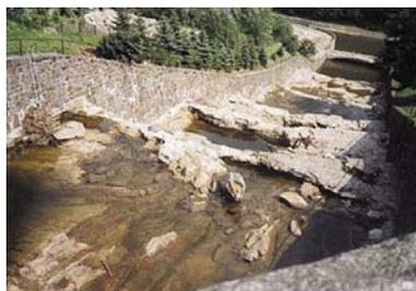
Talsperre Klingenberg: Beschädigte Hochwasserentlastungsanlage nach dem Hochwasser von 2002
