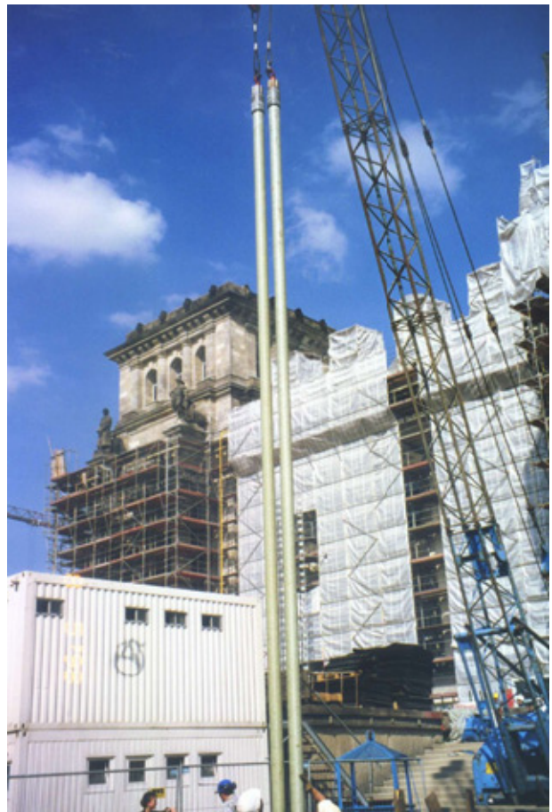
Abb. 7: Einzug der parallelen Pumpen- und Injektionsstränge (Quelle: Geothermie Neubrandenburg GmbH)
