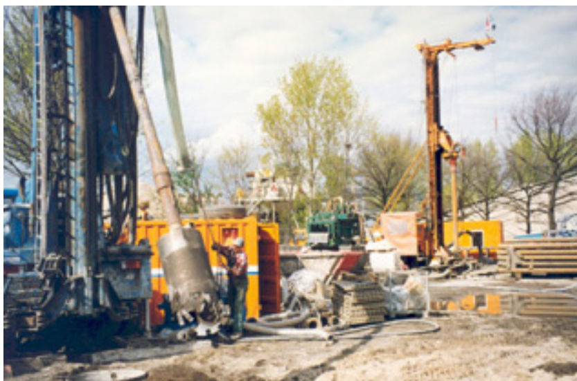
Abb. 8: Bohrarbeiten zum Kältespeicher im Bohrfeld Nord im Berliner Spreebogen (Quelle: Geothermie Neubrandenburg GmbH)
