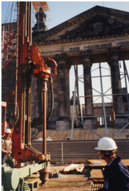
Abb. 1: Bohrarbeiten an der Wärme-speicherbohrung „Am Reichstag 1/96“ (Quelle: Geothermie Neubrandenburg GmbH)
