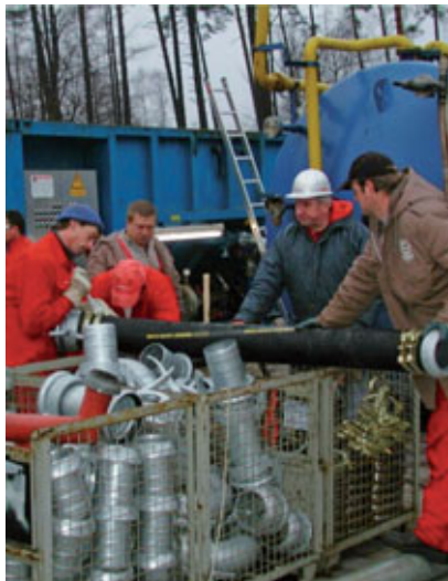
Abb. 8+9 Der nach der Stimulation durchgeführte Fördertest gibt Aufschluss über die Thermalwasserproduktivität und zeigt den Erfolg der Stimulationsmaßnahmen. (In-situ-Geothermielabor Groß Schönebeck, 2007)
