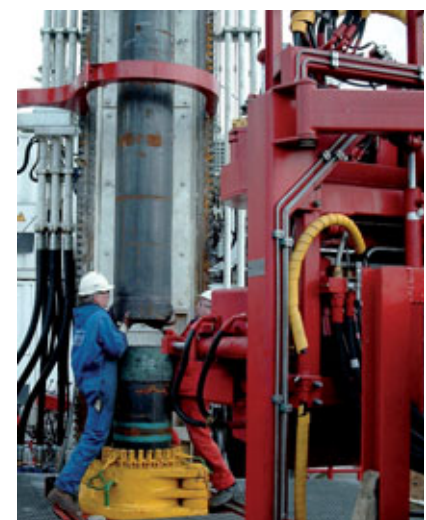
Abb. 7 Rohreinbau zur Sicherung der Bohrung, Geothermiebohrung Groß Schönebeck 4/05
