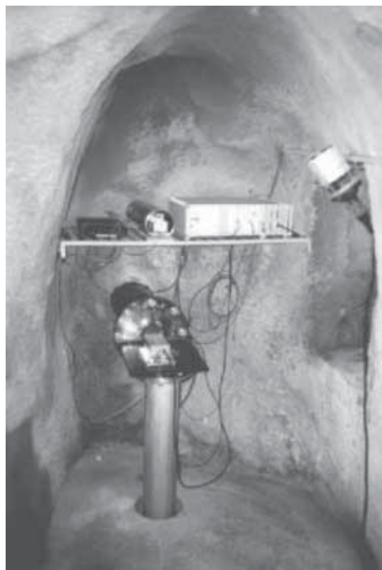
Abbildung 1: Installation des Laserstrainmeters im Stollen des Geodynamischen Observatoriums Moxa
