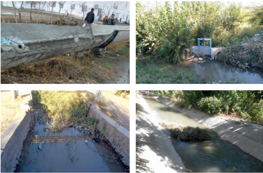
Abb. 2: Maroder Zustand von Bewässerungskanälen in Usbekistan (hier: Region Bukhara) (Fotos: A. Hamidov, Humboldt-Universität Berlin)
