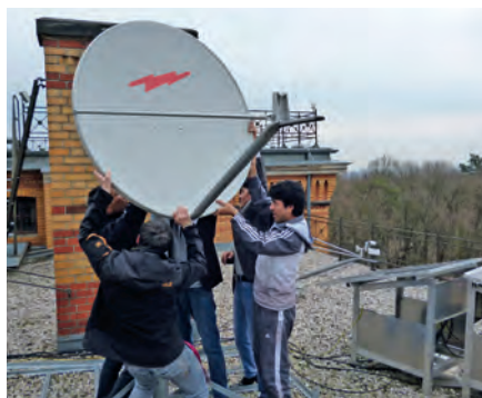
Links: Auch praktische Übungen gehören dazu: Auf dem Dach eines GFZ-Gebäudes üben afghanische Wissenschaftler den Aufbau einer VSAT-Anlage; diese wird von den CAWa-Stationen zur Übertragung der Messdaten genutzt. Rechts: Neben Vorlesungen und Übungen wurde in den Arbeitsgruppen Diskussionsrunden angeboten (Fotos: GFZ).
