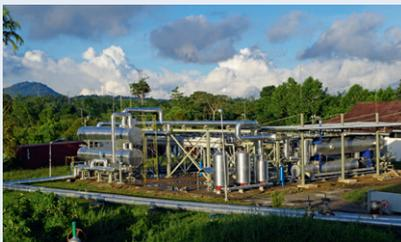
Geothermisches Niedertemperatur-Demonstrationskraftwerk in Lahendong, Indonesien (Foto: GFZ)
