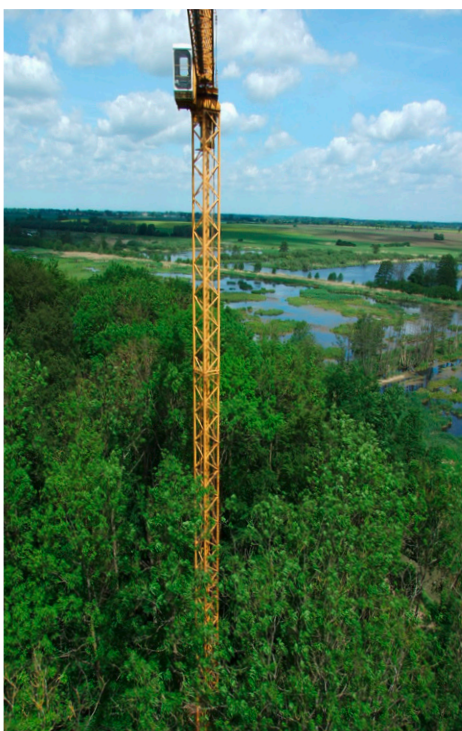
Blick aus der Personengondel. Messungen werden jedoch in Zukunft am Anleger des Krans abgelesen.
