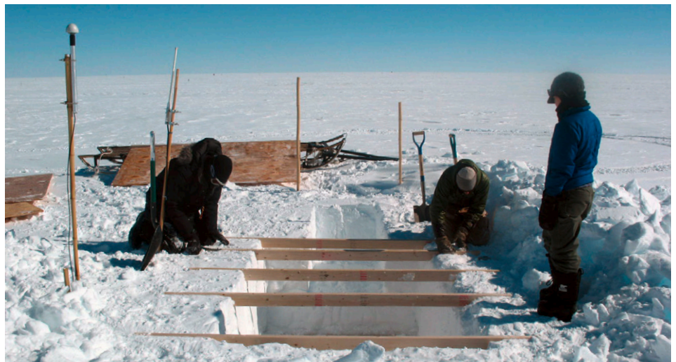
Bau der Seismometer-Kammer im Summit Camp (Foto: J.Schütte, GFZ)
