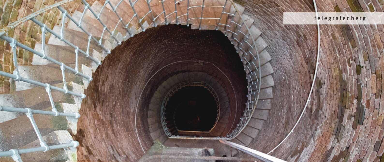
▲ Blick in den Tiefbrunnen (Fotos: Hecht, GFZ).
