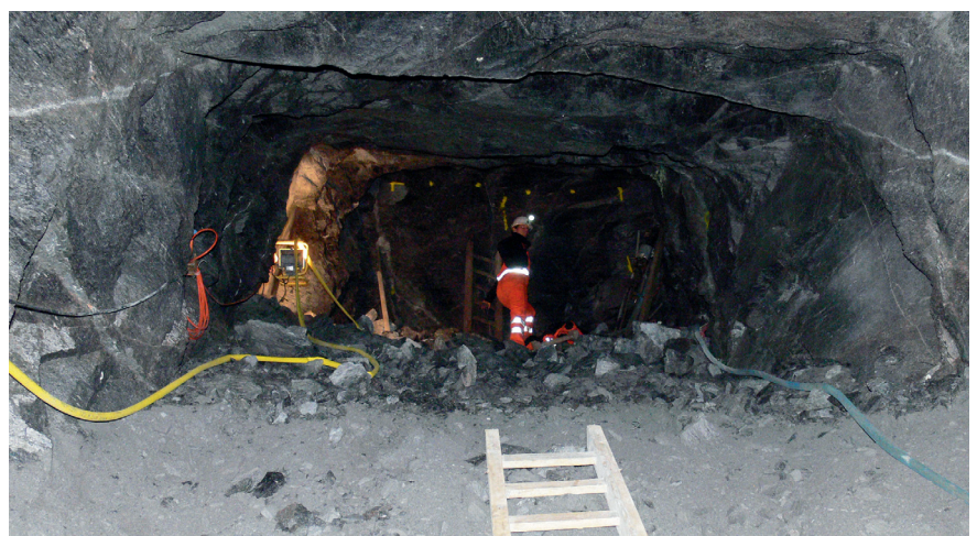
Ausbruch des ansteigenden Stollens (Steigort) im GFZ-Untertagelabor im Lehr- und Forschungsbergwerk „Reiche Zeche“ der TU Bergakademie in Freiberg
