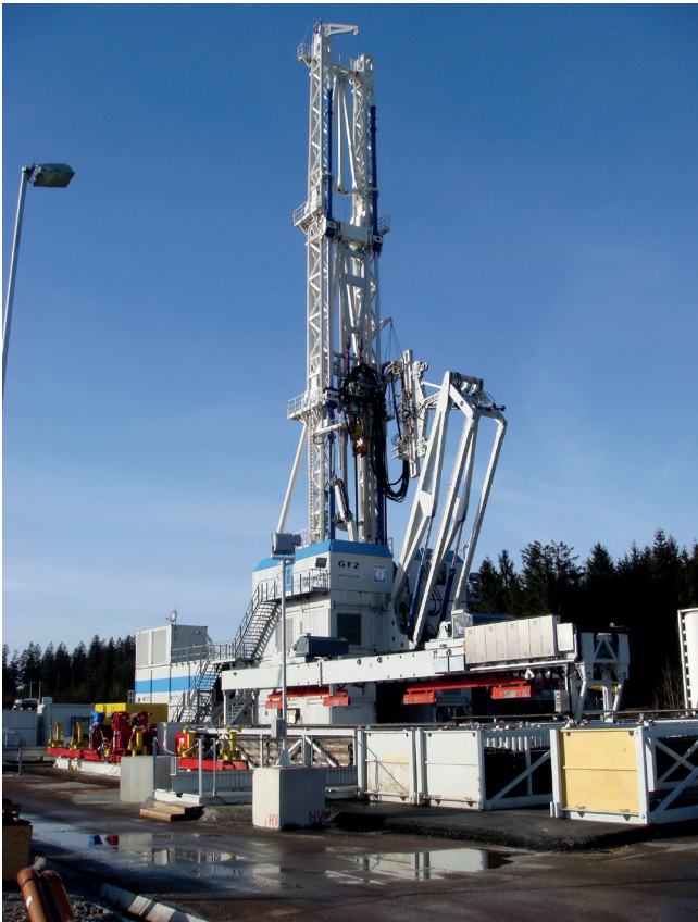
Abb. 5: Die GFZ-Bohranlage InnovaRig beim Abteufen einer Geothermiebohrung in Dürrenhaar/Bayern
