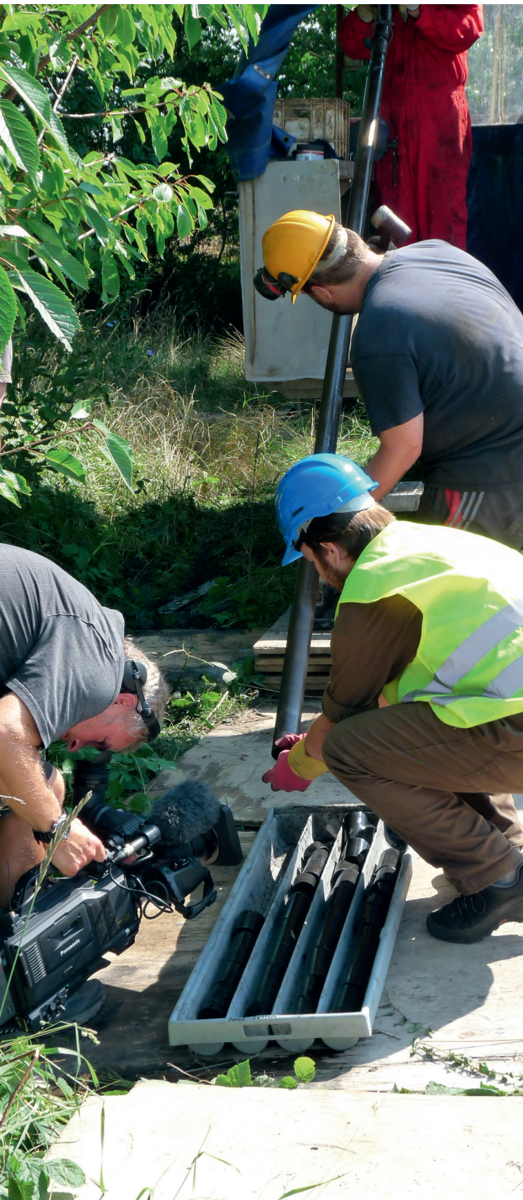
Abb. 7: Ein frischer Bohrkern des Alaunschiefers wird aus dem Gestänge gezogen und in die Kernkisten zur weiteren Bearbeitung gelegt. Die Bohrarbeiten auf Bornholm im August 2010 waren für die Öffentlichkeit von großem Interesse. Die Aktivitäten wurden gefilmt und waren noch am selben Abend im lokalen Fernsehen zu sehen.
