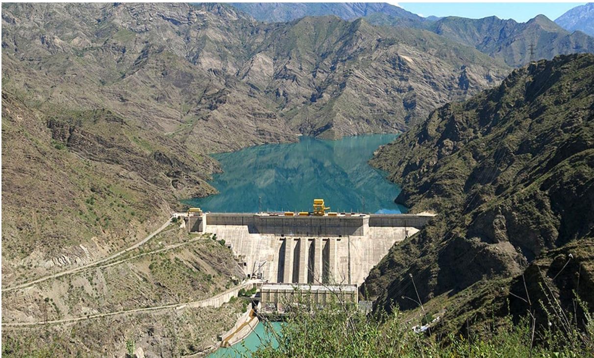
Abb. 1: Der Kurpsai-Staudamm am Fluss Naryn in Zentralkirgistan. (Foto: © Marco Pilz, GFZ)
