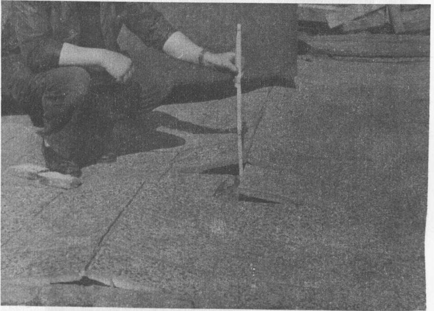
Bild 7: Fußbodenaufwölbung in der Stauchungszone
