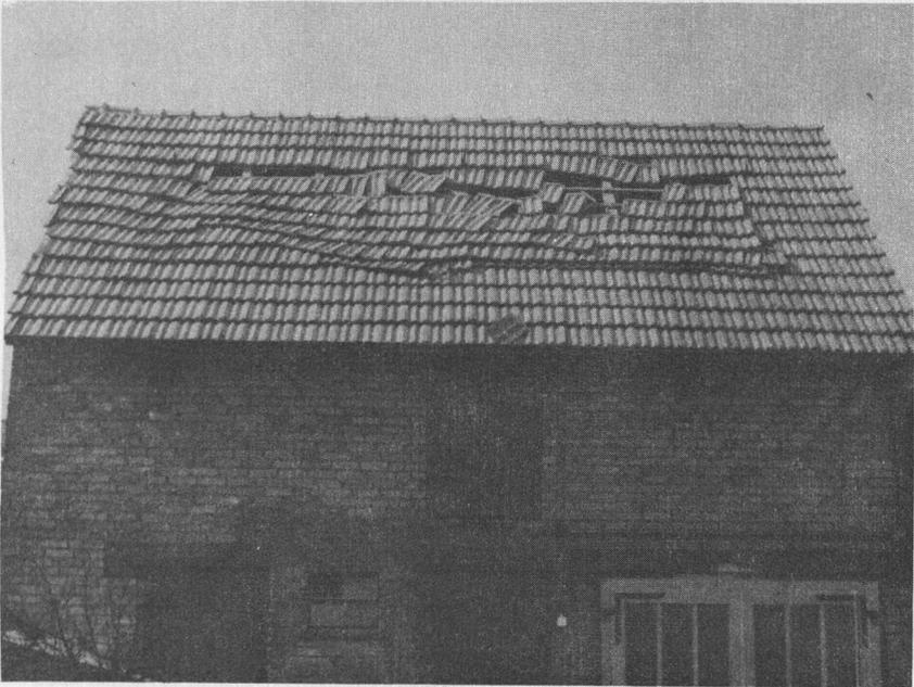
Bild 8: Wirkung einer Scherwelle auf ein Ziegeldach
