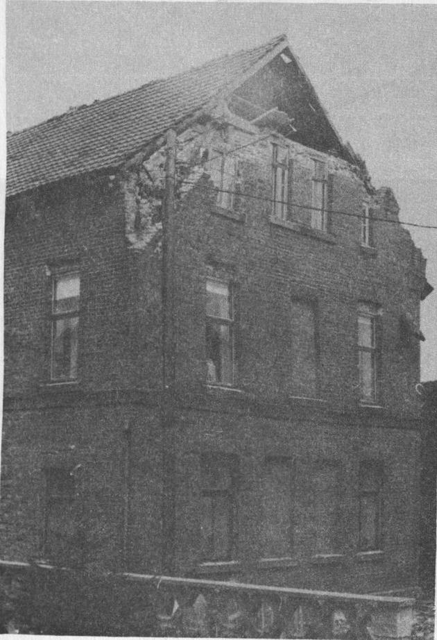
Bild 6: Massivgebäude ohne Verankerungen in den Außenwänden
