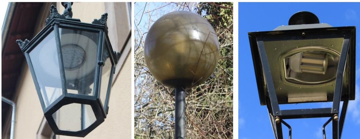
Abbildung 27: voll abgeschirmte Altstadtleuchten durch entsprechendes LED-Modul im Dach, Mitte: ineffiziente Kugelleuchte, Rechts: "Maiskolben" Lampen als Retrofit-Lampen (Bildquelle: Wiedergabe mit freundlicher Genehmigung von A. Hänel).
