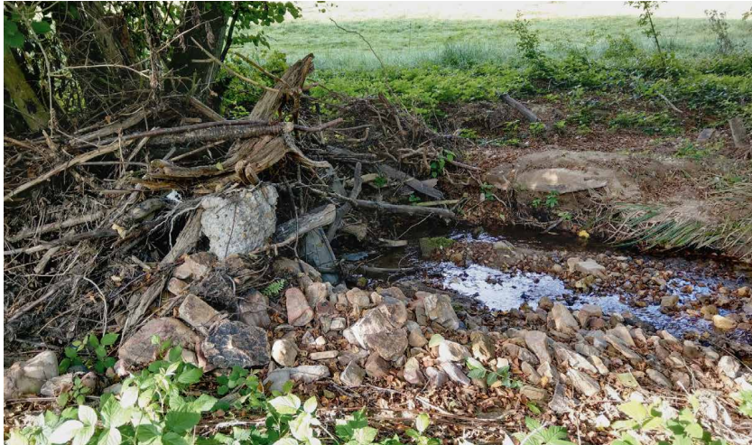
Verstopfung eines kleinen Zuflusses der Ahr durch hölzerne Abfälle (Foto: M. Dietze, GFZ)
