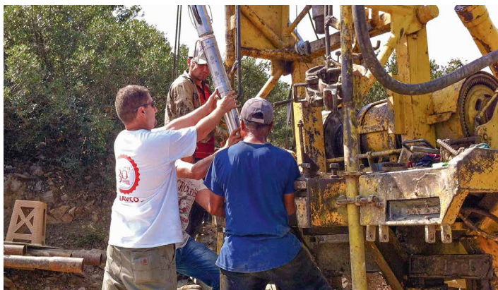
Einbau eines Bohrloch-Strainmeters in einer GONAF-Bohrung in der Türkei. Diese Geräte können komplementär zu klassischen Seismometern auch langsame Deformationen im Untergrund bis zu der Dimension eines Atomdurchmessers ( 10^{-10} m) messen. (Foto: M. Bohnhoff, GFZ)
