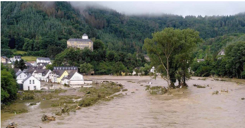
Hochwasser in Altenahr-Kreuzberg (Creative Commons CC0 1.0)
