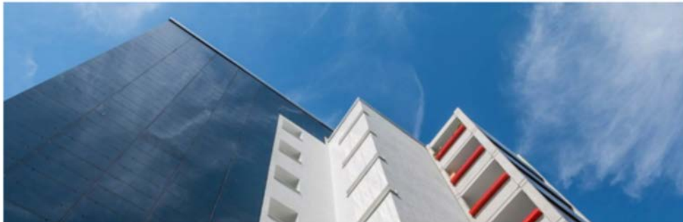
Bestandssaniertes Wohnhaus mit Photovoltaik in der Fassade. Foto: GEWOBA
