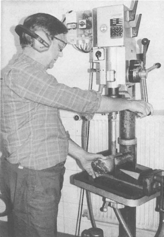
Abb. A.1.3: Bohren von Mini- kernen
