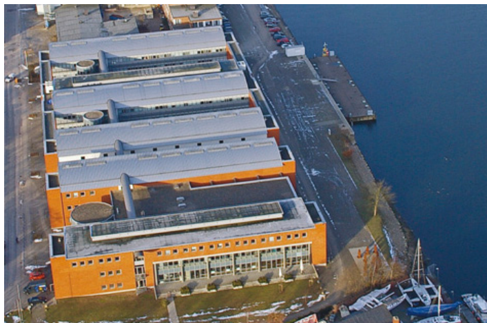
Das GEOMAR liegt auf dem Gelände des Seefischmarktes am Ostufer der Kieler Förde.
