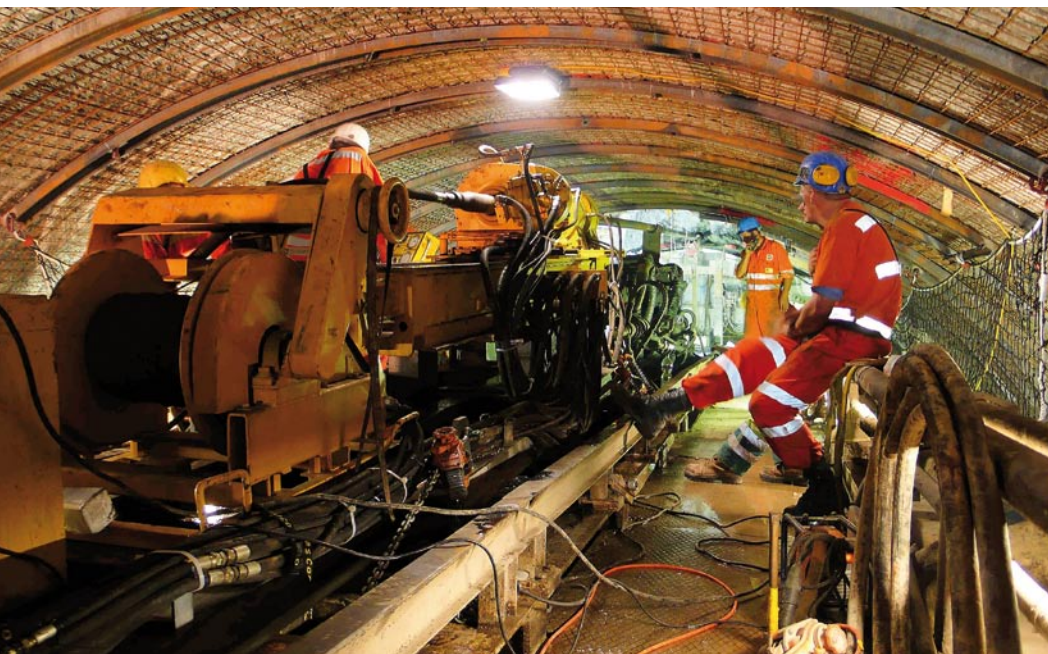
Arbeiter auf der Tunnelbohrmaschine im Gotthard-Basistunnel.
