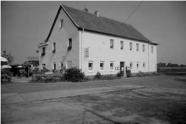
a) Schadensgrad D1: reine Durchfeuchtung Damage grade D1: Merely moisture penetration
