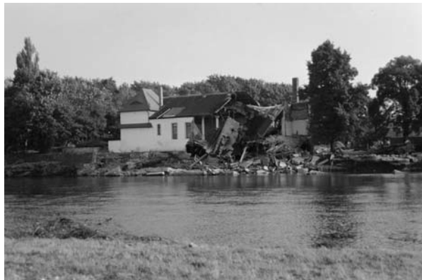
d) Schadensgrad D5: Kollaps des Gebäudes Damage grade D5: Collapse of the building
