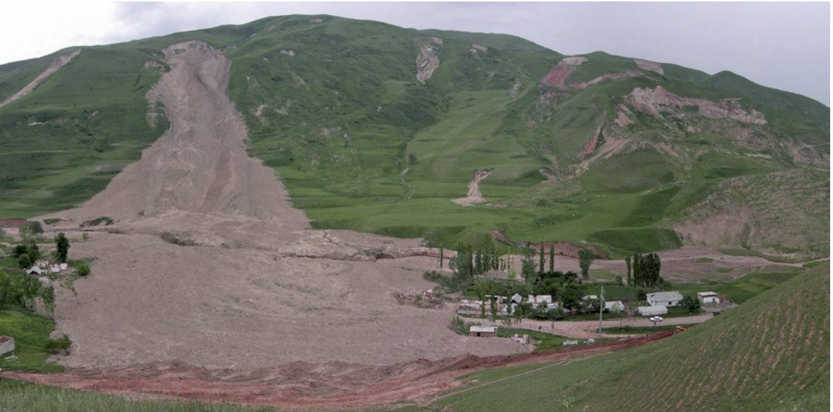
Hangrutschung Kainama in Süd-Kirgistan. Abgang 26.04.2004, Volumen ca. 2 Mio m 3 . Die Rutschmasse verschüttete Teile des Dorfes auf der anderen Flußseite, wobei 33 Menschen den Tod fanden (Geländefoto Juni 2004, GFZ Potsdam).
