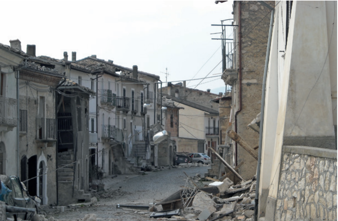
Erdbebenschäden in L'Aquila, Italien (Foto: GFZ)
