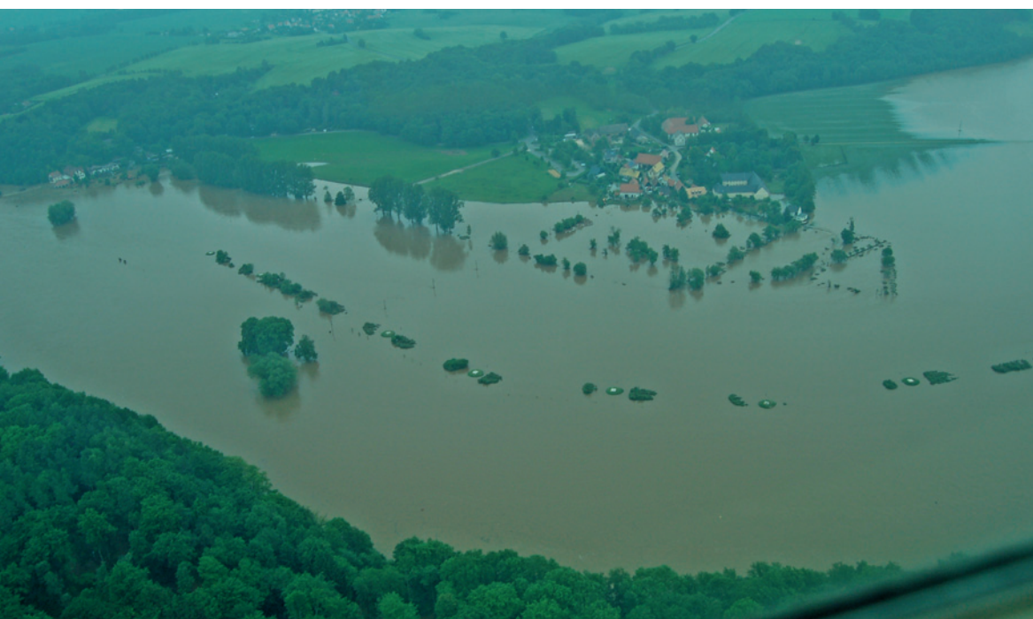
Hochwasser in Sachsen, Sommer 2013 (Foto: Janek Dreibrodt)
