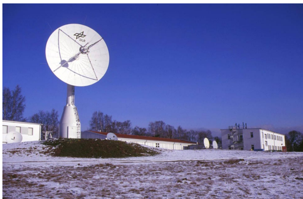
Abb. 5.2: 7,3 m-Empfangsantenne der Satellitenempfangsstation Neustrelitz.
