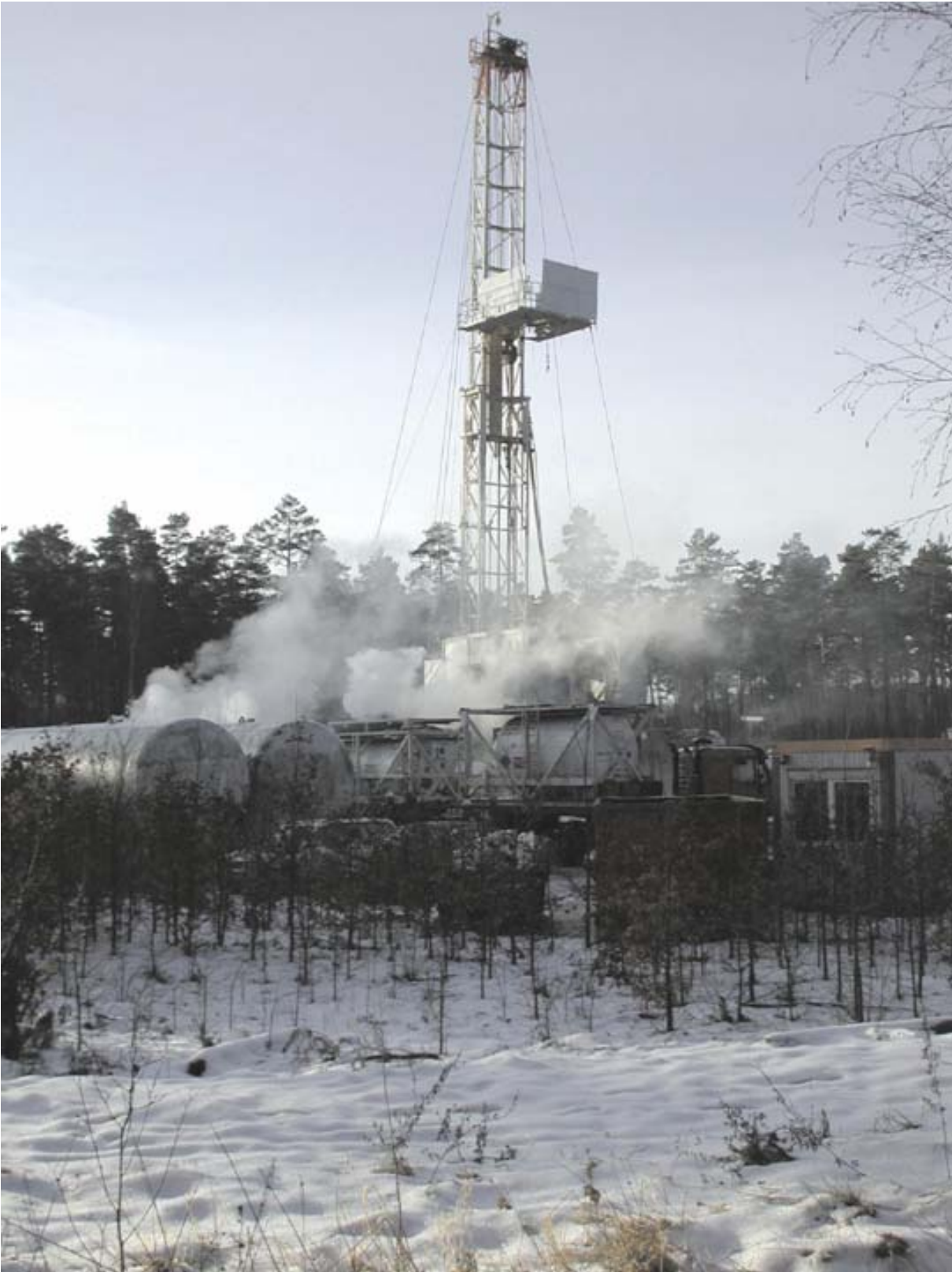
Abb. A-18 : Bohrturm während des Fördertests (Stickstofflift) am Standort Groß Schönebeck
