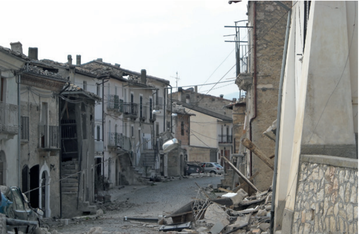
Erdbebenschäden in L'Aquila, Italien (Foto: GFZ)
