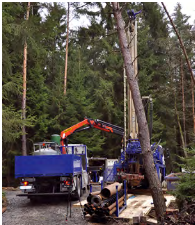
Aufbau der Bohranlage in Neualbenreuth.
