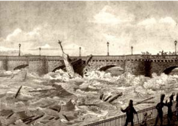
Augustusbrücke zu Dresden im Winter 1845 – Einsturz des Kreuzifix-Pfeilers während des schweren Hochwassers am 31. März 1845 um 9:30 Uhr (Bild: Sammlung M. Deutsch, Göttingen)
