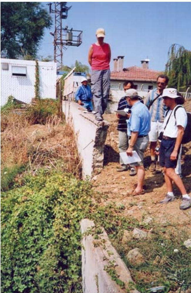
Abb. 1: Koseismischer Versatz einer Mauer in der Stadt Gölcük 10 km südwestlich von Izmit nach dem Izmit-Erdbeben 1999 mit einer Magnitude von 7,4.
