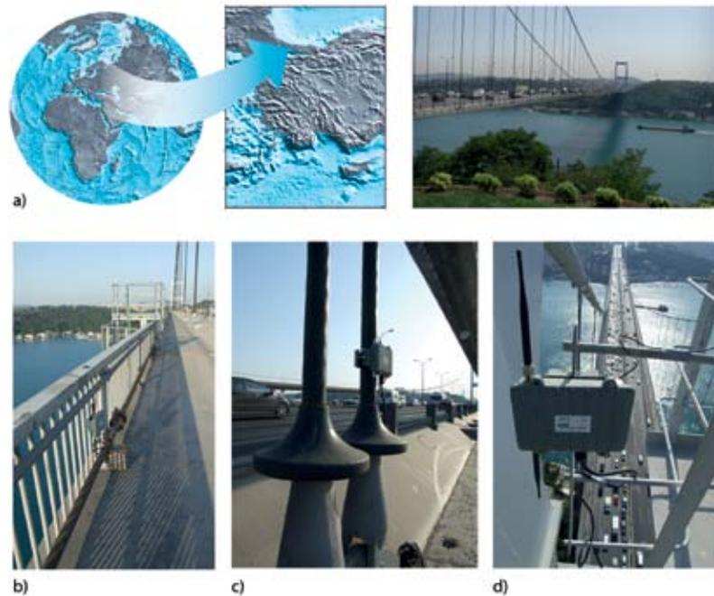
Abb. 5: (a) Lage der Fatih Sultan Mehmet-Brücke in Istanbul, die den Bosporus zwischen Hisarüstü (europäische Seite) und Kavacik (asiatische Seite) überspannt. (b), (c), und (d) zeigen beispielhaft Installationen der Sensoren während der Testmessungen im Juni 2008.
